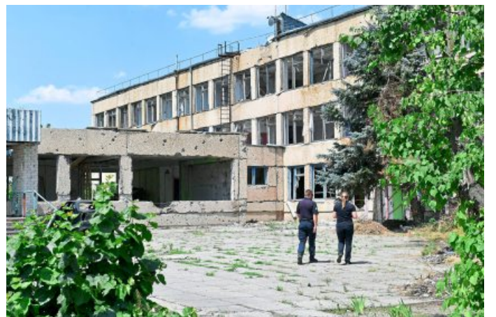
Völlig zerstört sind manche Gegenden in der Ukraine.
